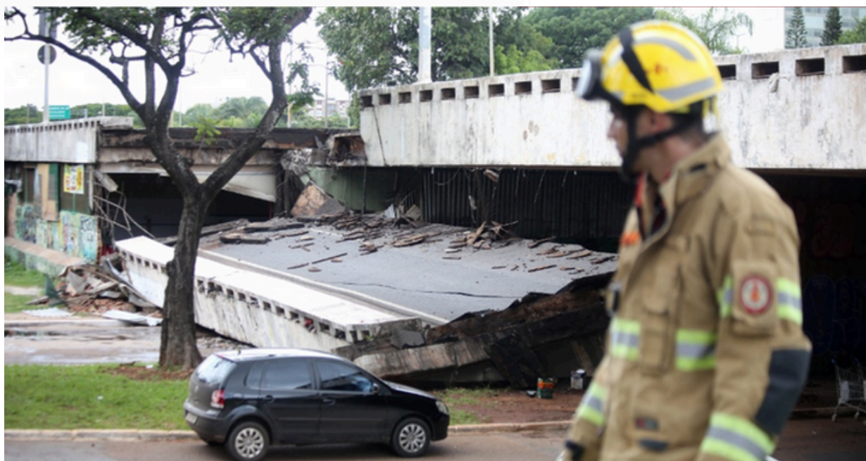
Viaduto da Galeria dos Estados, Eixão Sul, Fev/2018
