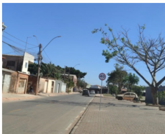
Pavimento asfáltico, pavimento intertravado e meios-fios (CT 22/2022)
