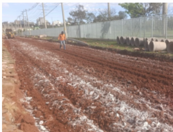
Sub-base em solo-cal.
