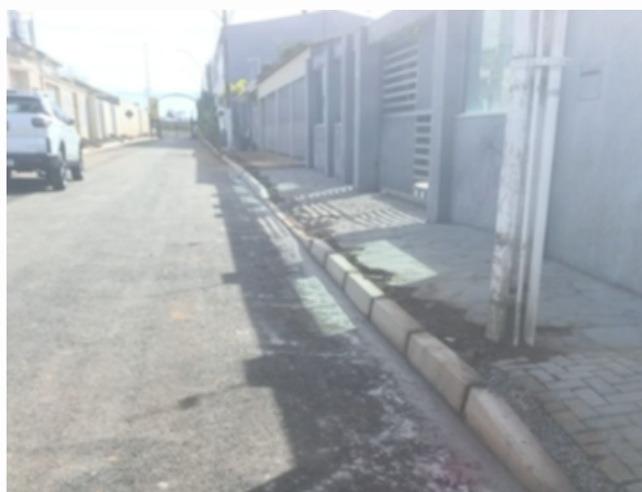
Pavimento asfáltico e meios-fios
