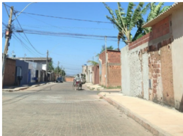
Pavimento intertravado, meios-fios e calçadas (CT 22/2022)
