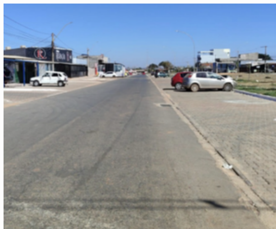
Pavimento asfáltico, pavimento intertravado e meios-fios (CT 23/2022)
