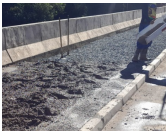
Concretagem da calçada da OAE e meios-fios.
