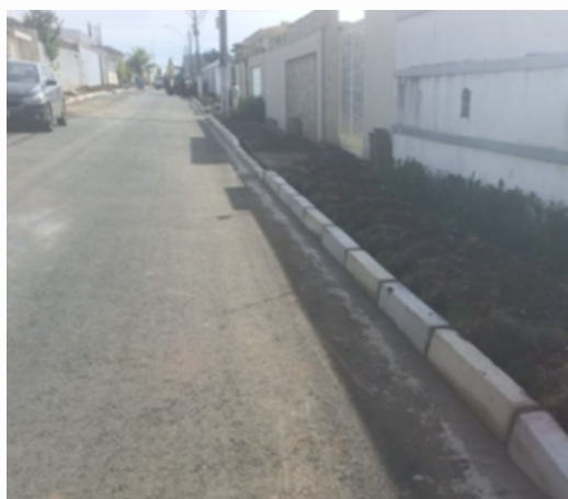
Pavimento asfáltico e meios-fios
