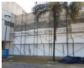
Figura 10 - Revitalização da área externa do Bloco CCO
