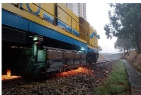
Figura 4 - Serviços de esmerilhamento/fresamento de trilhos
