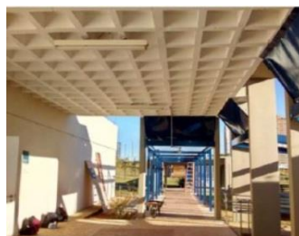
Figura 11 - Revitalização da área externa do Bloco A
