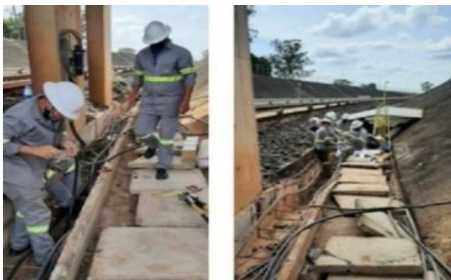
Figura 19 - Substituição de trechos de cabos
