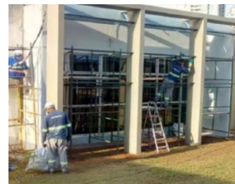
Figura 12 - Revitalização da área externa do Bloco A
