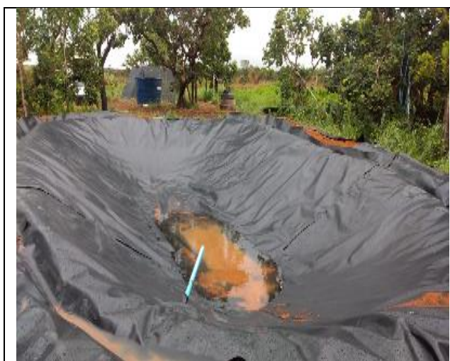
Foto 21. Implantação de geomembrana - tanque individual (54m 3 )
