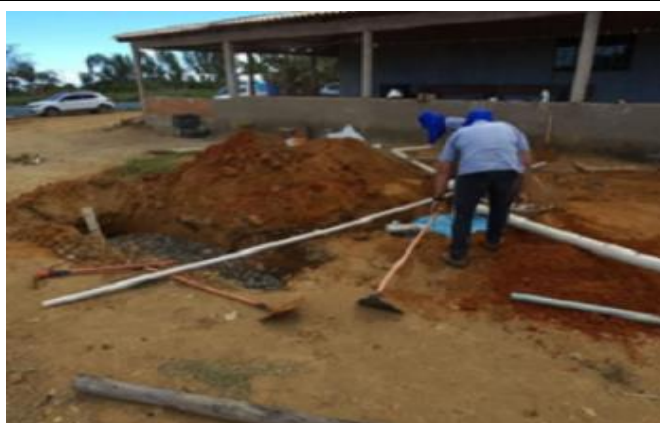
Foto 17. Instalação de sistema individual de esgotamento sanitário
