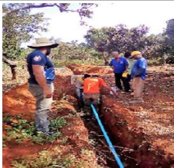
Foto 19. Instalação de rede enterrada
