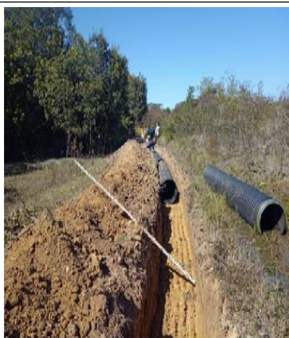
Foto 15. Instalação de tubulação no trecho do canal Tabatinga - 07/2021
