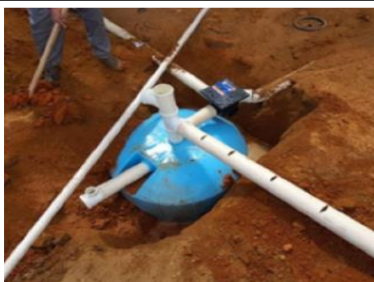
Foto 18. Instalação de sistema individual de esgotamento sanitário
