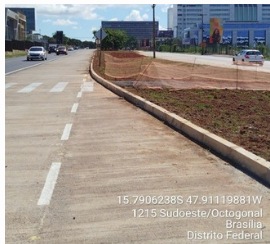
Trecho 6 - Calçada, meios-fios e grama.
