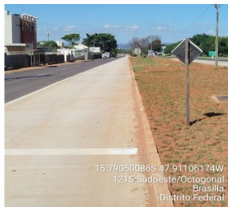
Trecho 4 - Pavimento asfáltico (flexível)
