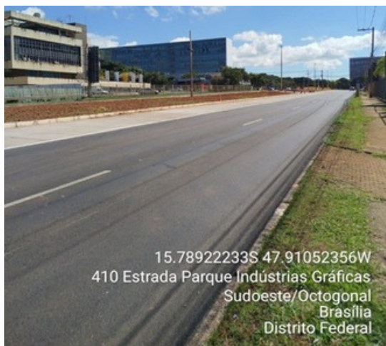
Trecho 6 - Pavimento asfáltico (flexível) e calçadas.
