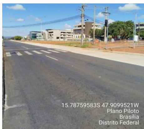
Trecho 4 - Pavimento asfáltico (flexível).
