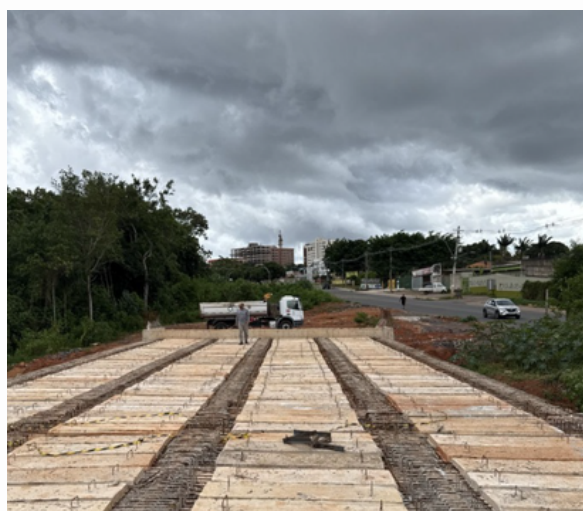
Pavimento asfáltico (flexível)
