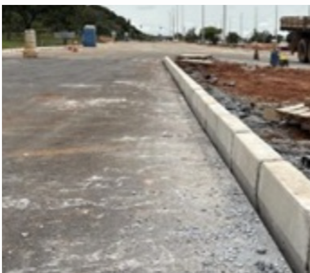
Assentamento de meios-fios - Trecho 2
