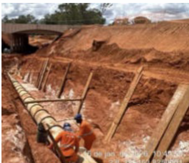
OAE sobre o córrego Vicente Pires
