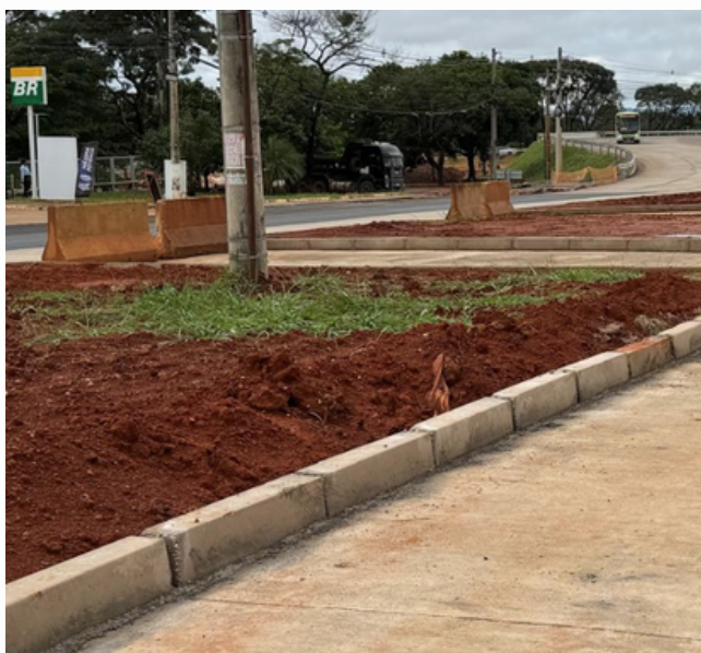
Calçadas e meios-fios - Trecho 4
