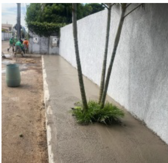
Calçada/assentamento de meios-fios.
