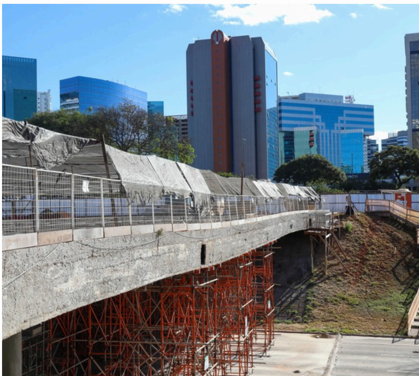
Oito anos do desabamento do Eixão Sul: GDF investiu em plano de recuperação de viadutos. Agência Brasília (06/02/2026).
