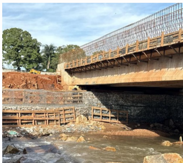
Muro de gabião - OAE sobre o córrego Vicente Pires
