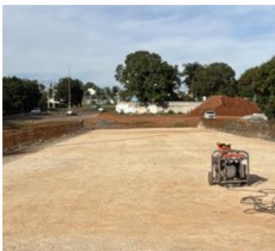
Laje da OAE sobre o córrego Vicente Pires
