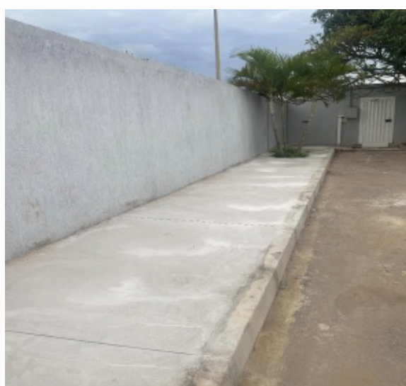
Calçada/assentamento de meios-fios.
