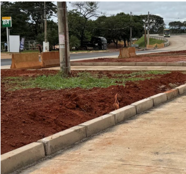
Calçadas e meios-fios - Trecho 4
