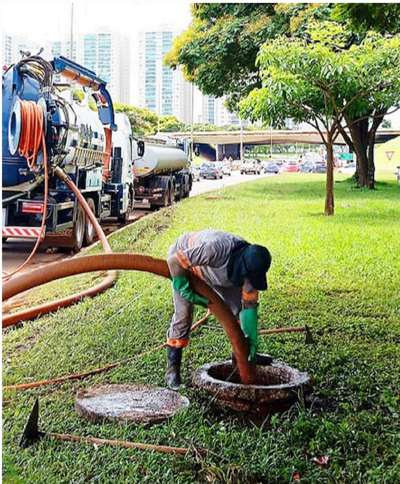
Novacap age rápido na limpeza de bocas de lobo e redes de águas pluviais após chuvas intensas em Taguatinga. Agência Brasília (08/02/2026).
