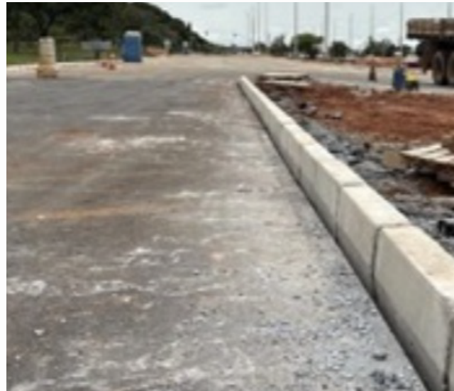
Assentamento de meios-fios - Trecho 2
