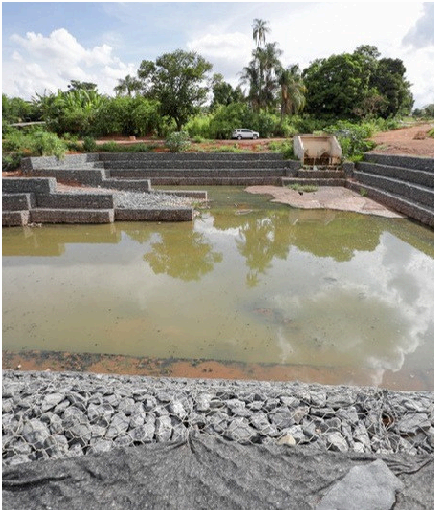
Nova rede de captação e escoamento de água da chuva em Vicente Pires leva mais segurança para a população. Agência Brasília (13/11/2025).
