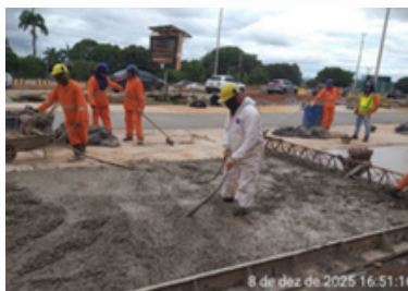
Concretagem do pavimento rígido
