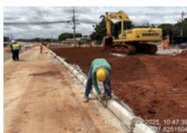
Pavimento rígido, assentamento de meios-fios e terraplenagem
