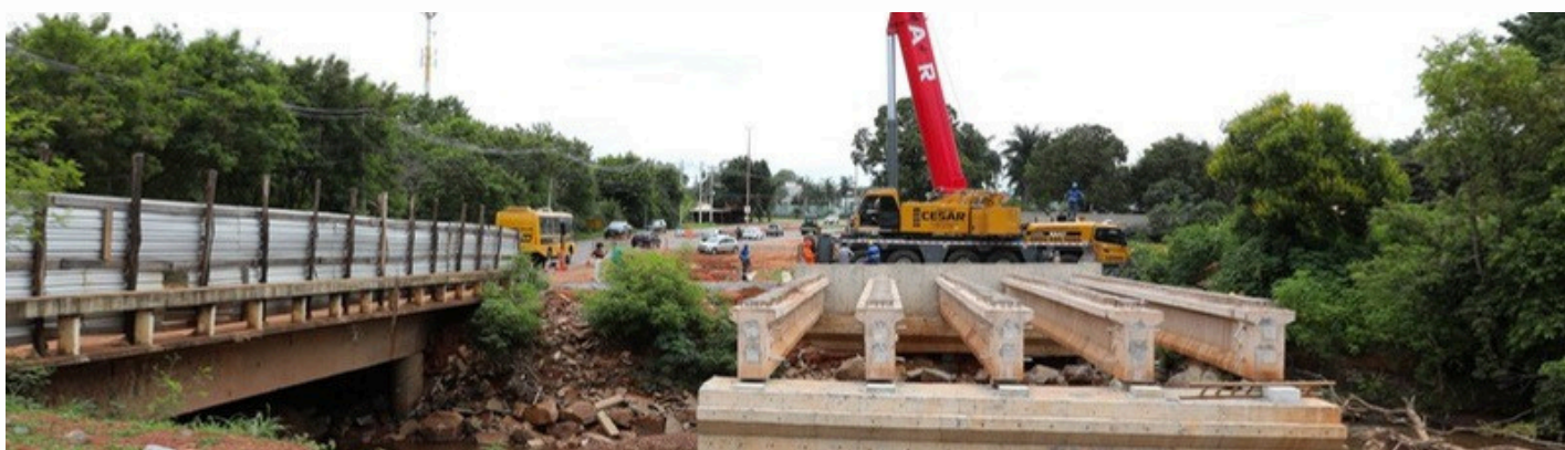
Vigas da nova ponte erguida entre Guar e Ncleo Bandeirante so iadas. Agncia Braslia (01/12/2025).
