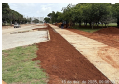
Pavimento intertravado, ciclovia e plantio de grama
