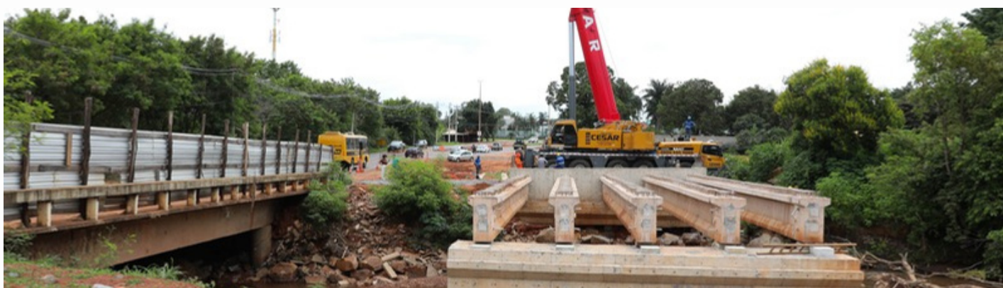
Vigas da nova ponte erguida entre Guará e Núcleo Bandeirante são içadas. Agência Brasília (01/12/2025).
