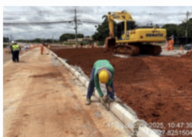
Pavimento rígido, assentamento de meios-fios e terraplenagem
