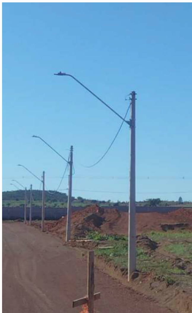
Rede de distribuição de energia elétrica e Iluminação – QD. 04 – Aldeias do Cerrado.
