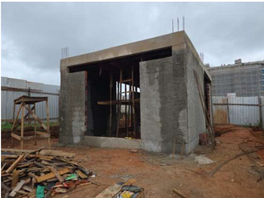
Construção civil da Estação Transformadora – ET 02 da quadra SQNW 305, Setor Noroeste.
