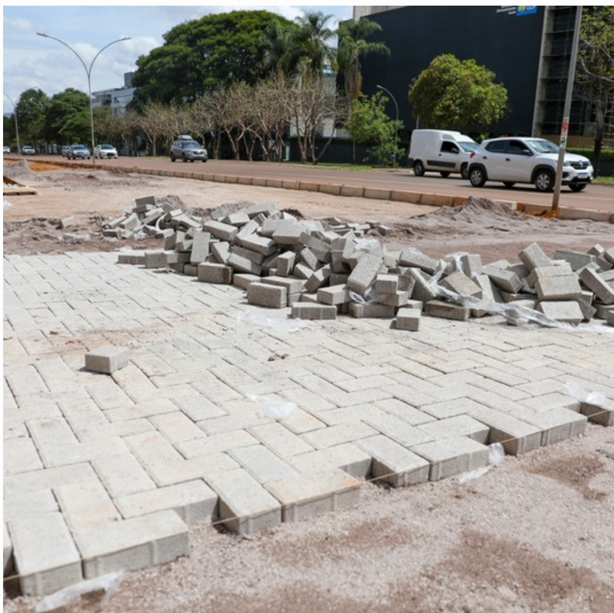
Equipes iniciam concretagem e instalação de bloquetes nas novas calçadas da W3 Norte. Agência Brasília (07/11/2025).
