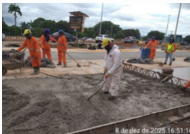
Concretagem do pavimento rígido
