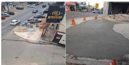
Construção de Calçadas na Rua 3.
