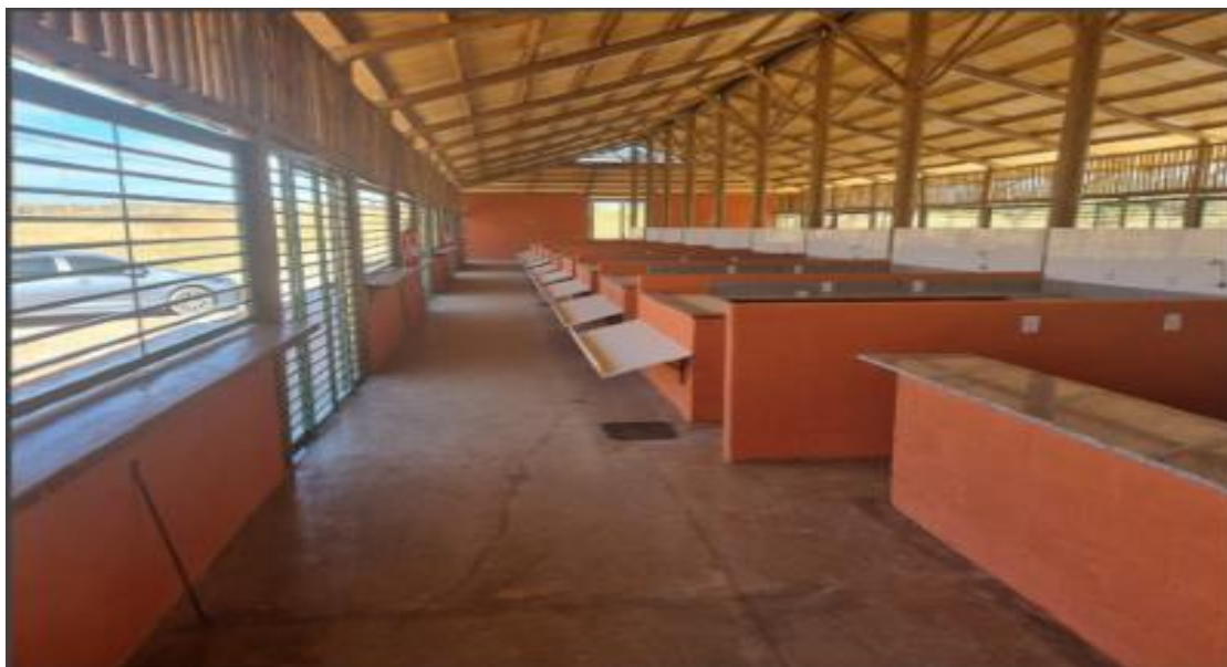
Figura 2. Obra concluída e entregue do Empório do Colorado
