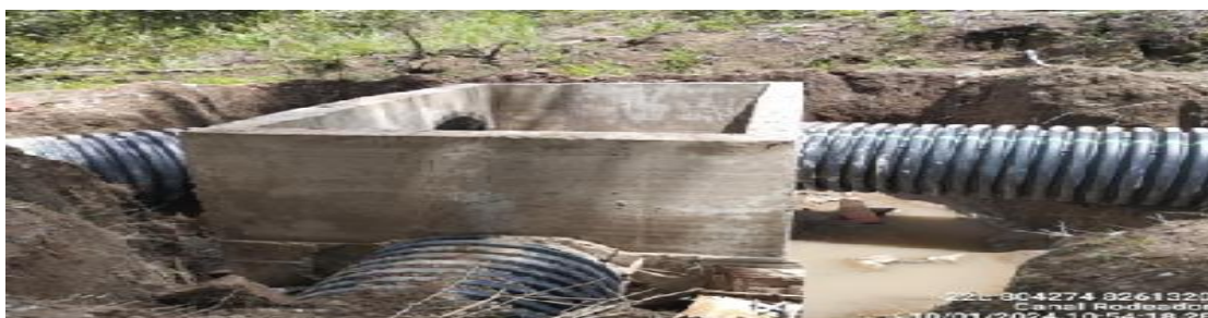
Figura 57. Obra de tubulação do canal Jardim II
