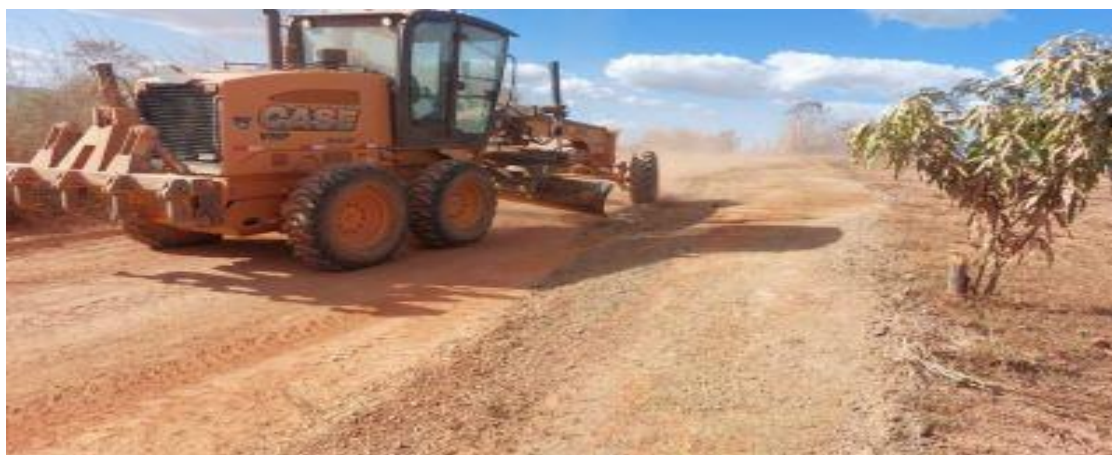
Figura 1. Atuação da Seagri-DF na infraestrutura das áreas rurais - manutenção de estradas rurais não pavimentadas
