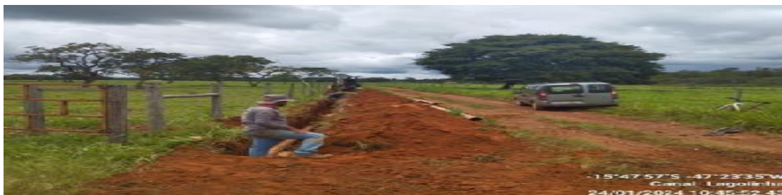
Figura 56. Instalação de tubulação no trecho do canal Capão Comprido I
