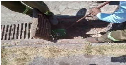
Limpeza e desobstrução de Bocas de Lobo
