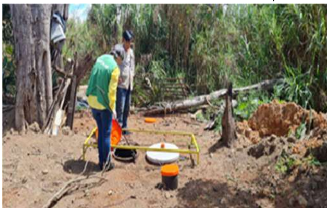
Figura 41 - Instalação de sistema de esgotamento sanitário
