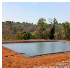
Figuras 84, 85, 86 e 87 - Revestimento de reservatórios
