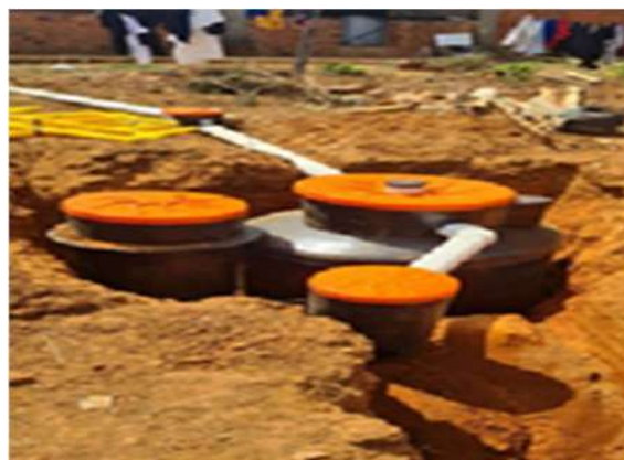
Figura 42 - Sistema de esgotamento sanitário individual
