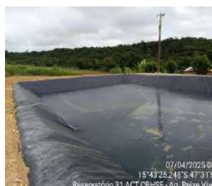
Figuras 84, 85, 86 e 87 - Revestimento de reservatórios
