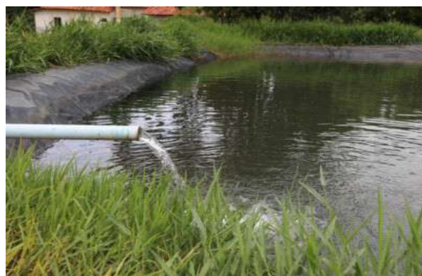
Tubos PEAD - Para tubulação de canais de irrigação (esquerda), e tanques lonados com membrana impermeabilizantes (direita).
