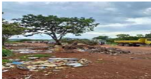
Retirada de entulhos em Arapoanga
