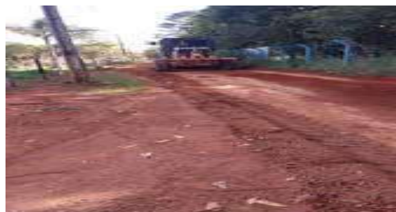
Terraplanagem em Arapoanga
