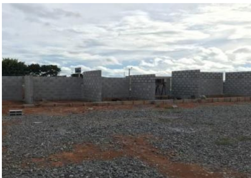
Foto 3 - PEV de Santa Maria em construo
