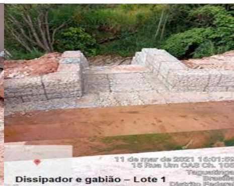
Dissipador e gabião – Lote 1
