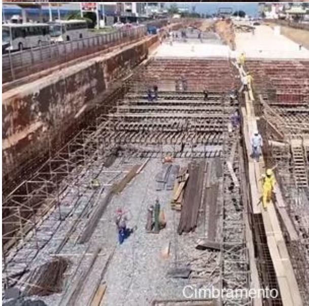
Execução de formas da laje de topo
