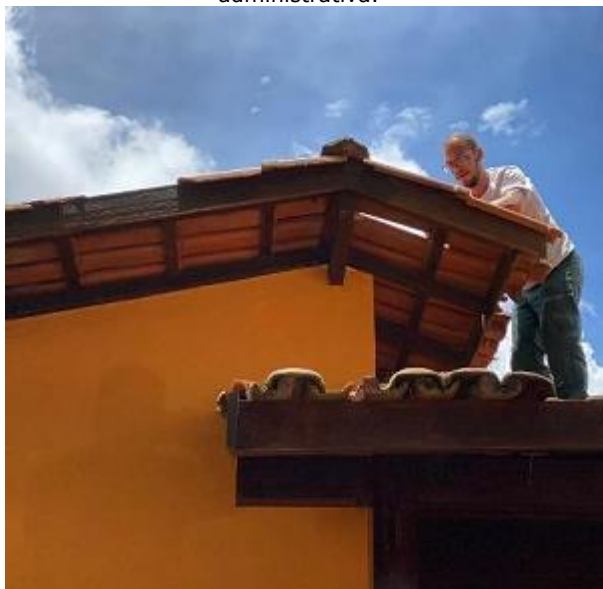
Figura 7. Recuperação do telhado da sede administrativa.
