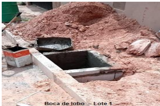
Boca de lobo – Lote 1
