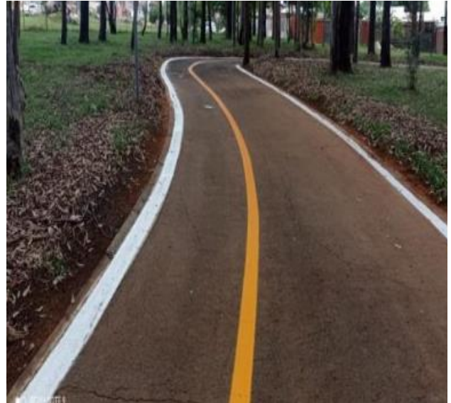
Figura 4. Pintura e Sinalização de pista interna.
