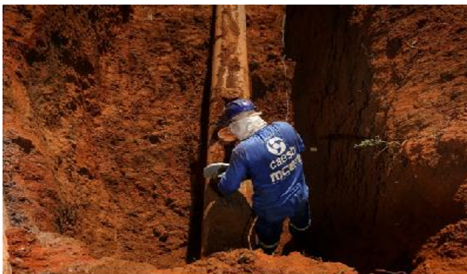
Figura 1 – Implantação de Adutora de Água Tratada em Sobradinho
