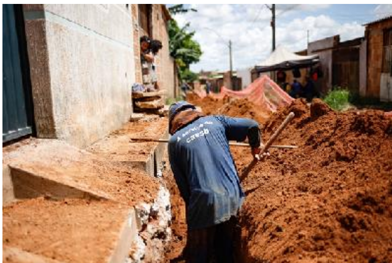
Figura 3 - Implantação de rede de esgotamento sanitário no Sol Nascente
