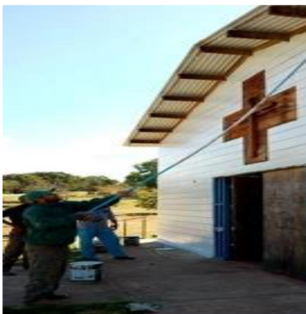
Figura 9. Revitalização da Capela São Geraldo
