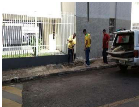
Reconstrução de Calçadas
