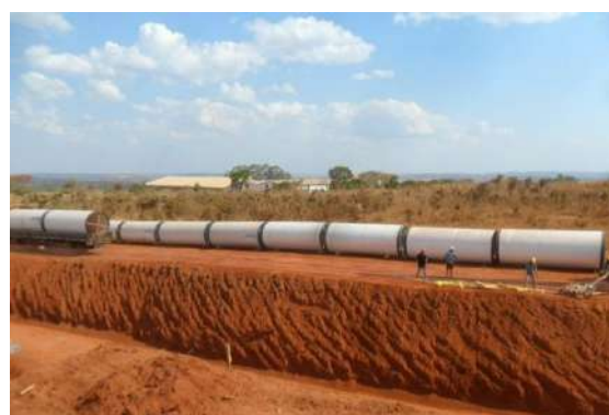
Adução de Água – Sistema Corumbá
