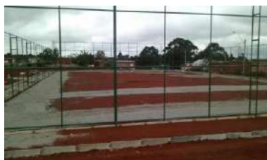
Fotos da Quadra 501, Setor Habitacional Sol Nascente
