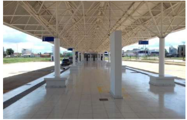
Figura 2 – Terminal Recanto das Emas II – inaugurado em agosto/2016
