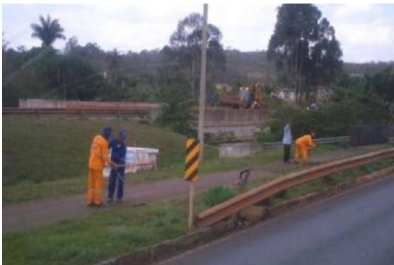
Roçagem e Capina - Serviço realizado pela NOVACAP.
