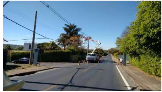
Reparo e limpeza de caixa de contenção - Serviço realizado por esta RA XVIII em parceria com NOVACAP.
