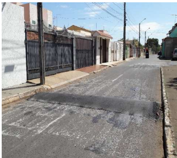
Construção de Quebra-Molas – Cruzeiro Velho
