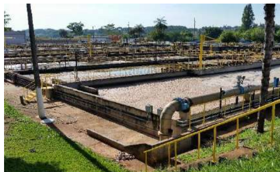
Melhorias Operacionais realizadas nas ETE's Sul e Norte
