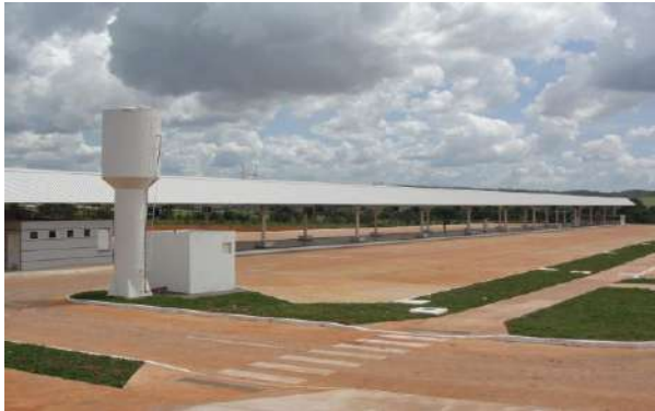
Figura 3 – Terminal Samambaia Norte – concluído em 2016 e inaugurado em janeiro/17
