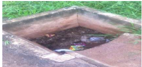
Reparo e limpeza de meio fio e boca de lobo - Serviço realizado por esta RA XVIII em parceria com NOVACAP.
