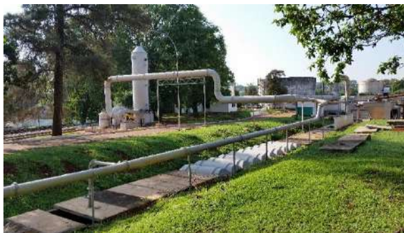
Melhorias Operacionais realizadas nas ETE's Sul e Norte
