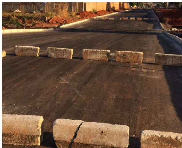
Pavimentação asfáltica de ligação dos Trechos 04 ao 17
