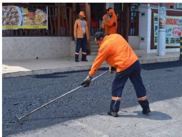
Recapeamento de Asfalto – Parceria Novacap
