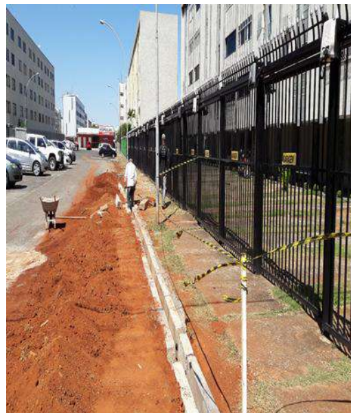
Construção de Drenagem para Escoamento de Águas Pluviais – Cruzeiro Novo
