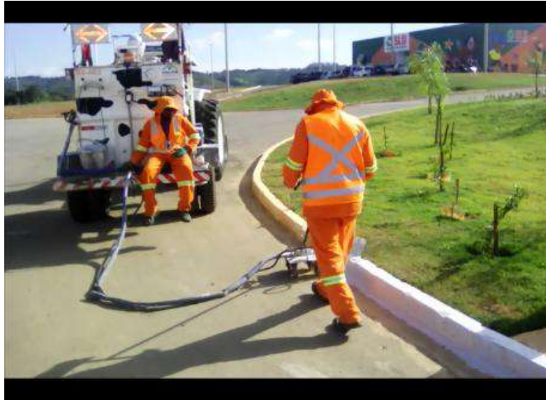
Foto 2: Pintura mecanizada de meios-fios
