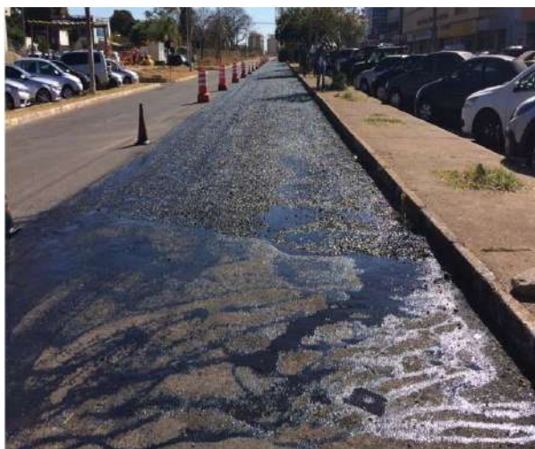
Recapeamento do estacionamento nas Quadras 2, 3 e 5C
