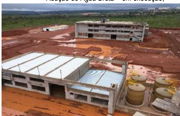
Estação de Tratamento de Água – Sistema Corumbá
