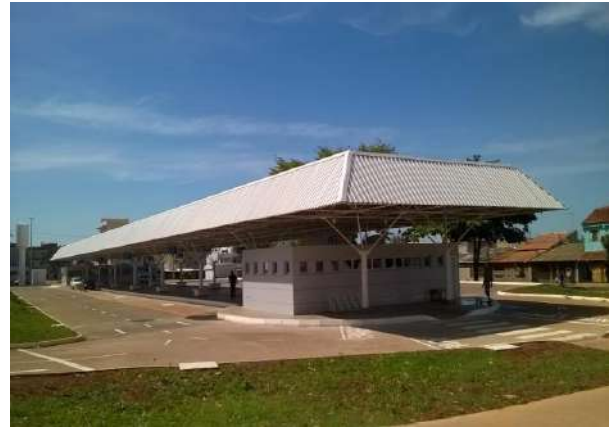
Figura 10 – Terminal P Sul – inaugurado em novembro/2016
