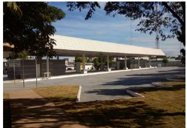
Figura 6 – Terminal Paranoá - inaugurado em julho/2016
