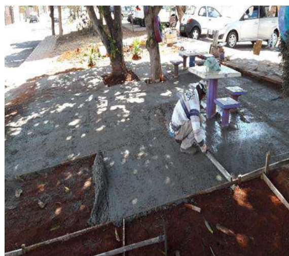
Construção de Calçadas nas Praças
