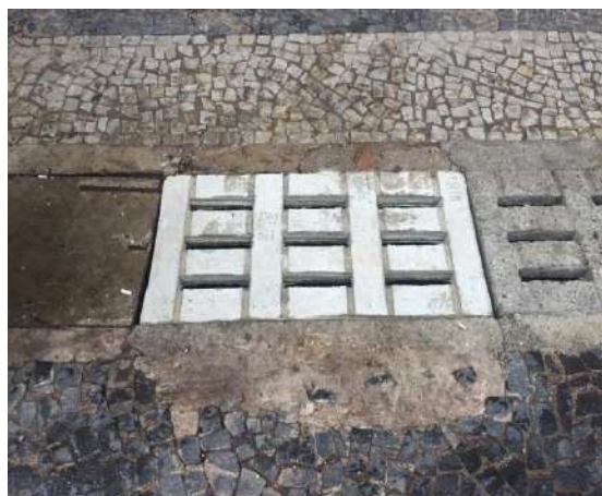
Troca de Tampa de Bueiros
