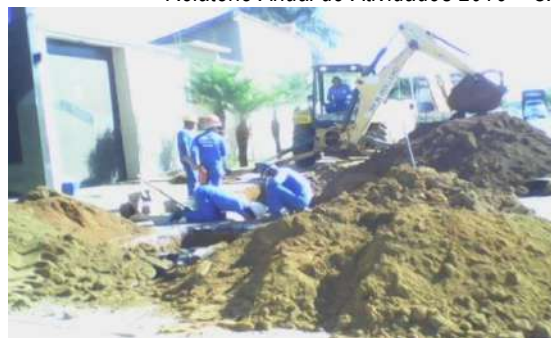
Ligações de esgoto executadas em Vicente Pires
